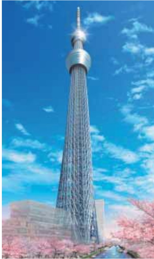
■写真7 首都圏地上デジタル放送の電波塔となる
