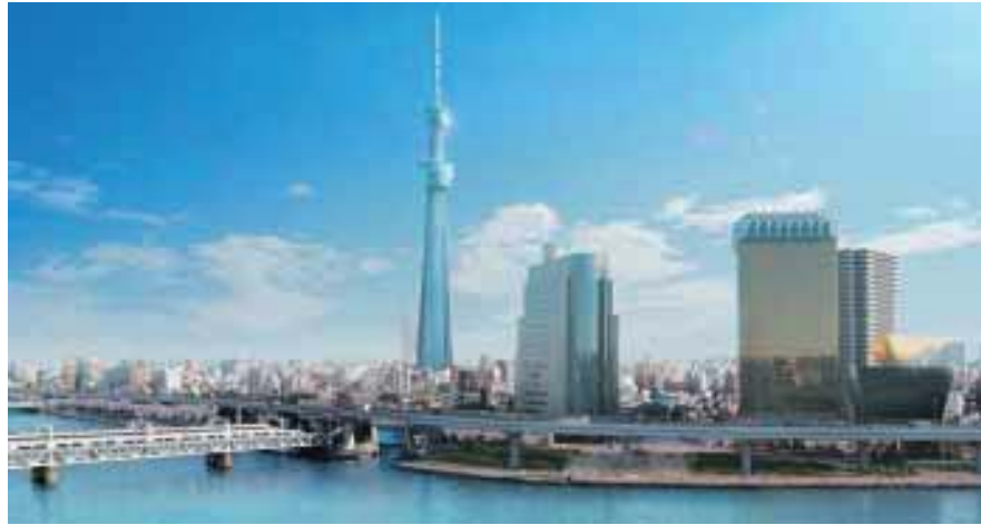
■写真1 2011年度、完成予定の高さ610mの新タワー
