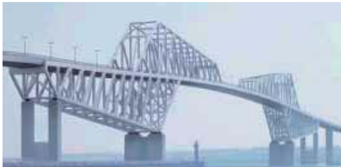
橋長760mの鋼3径間連続トラス・ボックス複合橋。上部構造のデザインは港の景観として特徴的なガントリークレーンをイメージしたもので、長大橋梁の構造としては世界に類が無く東京港の玄関口に相応しいゲート性とモニュメンタル性を備えた美しいデザインとなっている。
