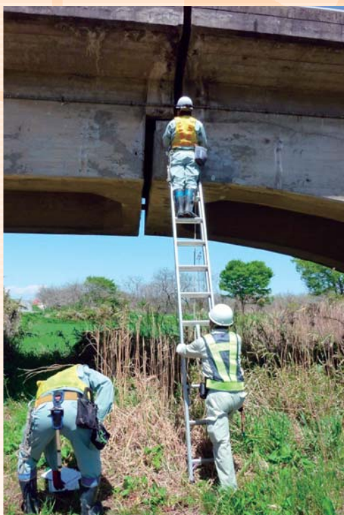
■隙間があいた橋梁の調査
