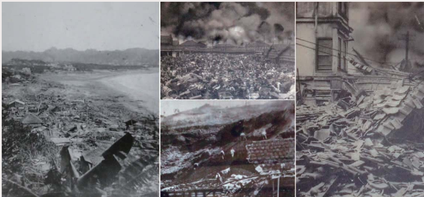
■ 関東大震災の被害の様子 右：築地交差点付近の惨状（一部）（写真提供 復興記念館） 中上：上野駅周辺の火災と避難者（一部）（写真提供 復興記念館） 中下：お茶の水付近の崖崩れ（一部）（写真提供
