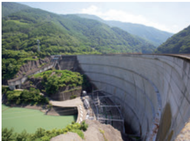
■国道から少し離れてひっそりしている水殿ダム
