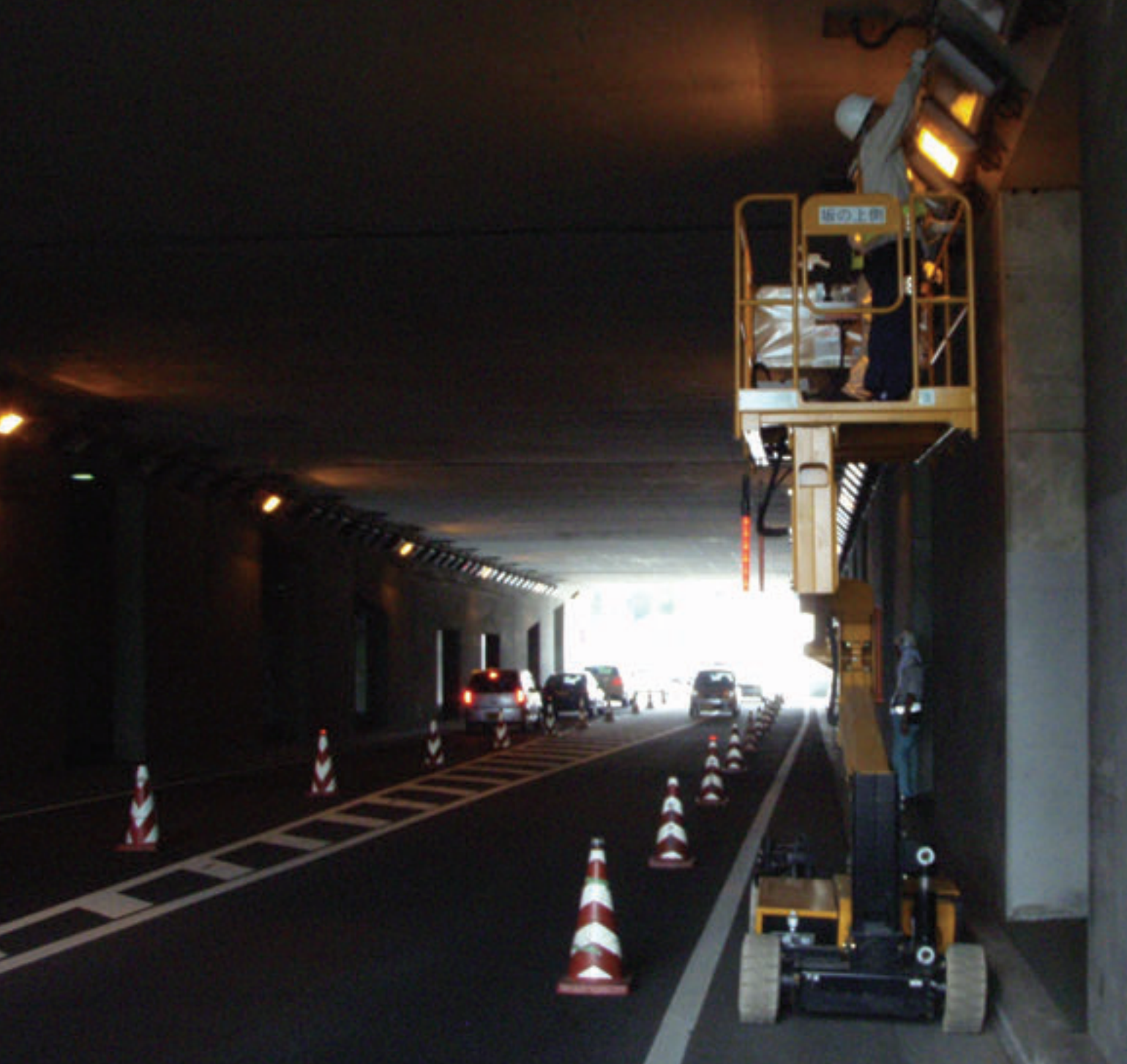
トンネル内の付属物（照明灯）の点検作業の様子
