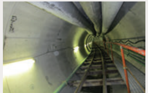
■ 大規模なシールド工事もある下水道（荒木氏提供）
