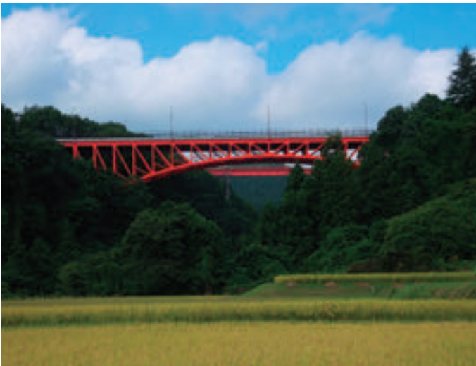
■国道48号 熊ヶ根橋 仙台市
