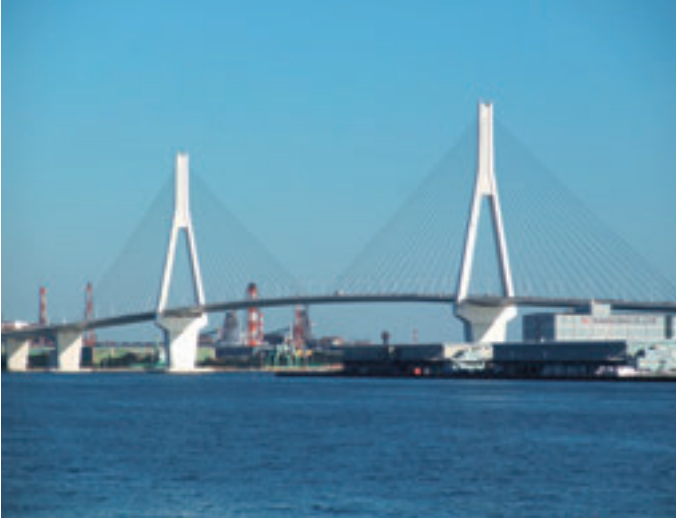
■首都高速道路 鶴見航路橋（つばさ橋） 横浜市
