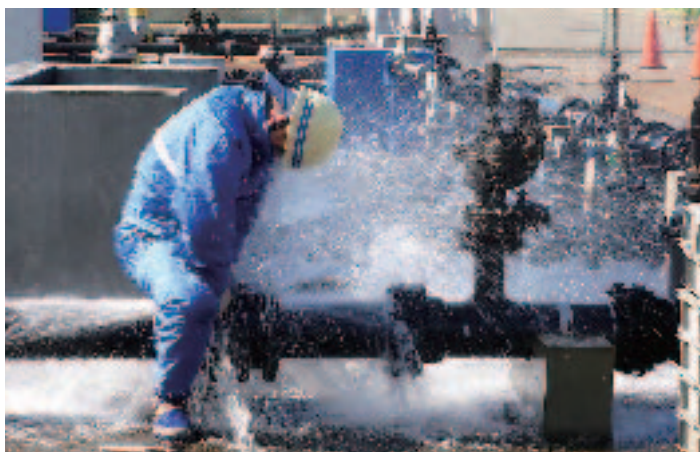
■水道実技研修の様子
