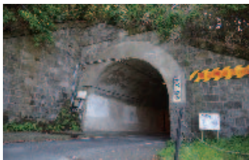
■走水第二隧道の豪壮な石積み坑門。アーチ部分には煉瓦が隠されている。明治9年に水道用として誕生し、明治16年に拡幅のうえ車道化された
