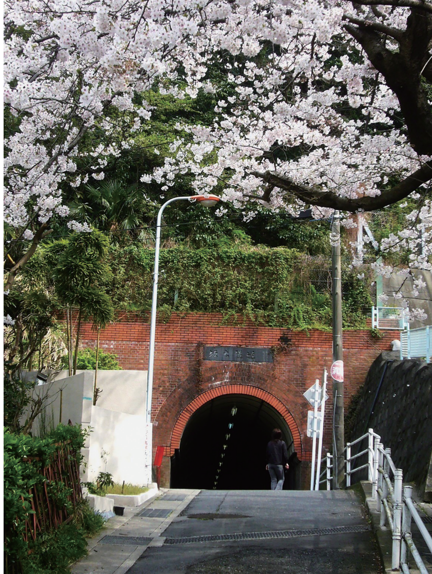
■小さな断面が特徴的な坂本隧道。もともとは水道管を通すために建設されたもの。大正10年完成
