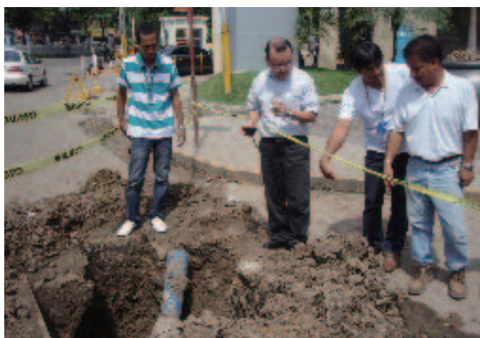
■確認調査配水管更新工事現場
