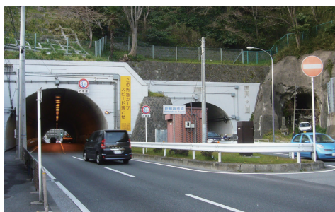
■国道16号の船越隧道。左から順に、新・旧・旧の坑口が並ぶ。旧旧隧道は明治26年に完成し、大正12年まで使われていた
