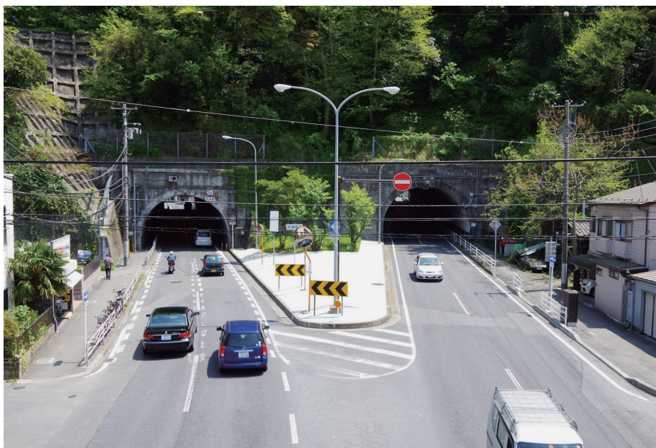
■横須賀市の大動脈、国道16号田浦隧道。向かって左は大正15年生まれ、右は昭和17年に増設された
