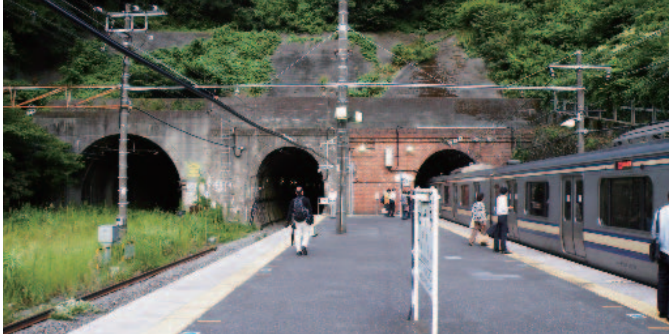
■田浦駅に停車中の列車。先頭車両が七釜隧道に入っている。3つの坑門の材質が異なっている事にも注目して欲しい
