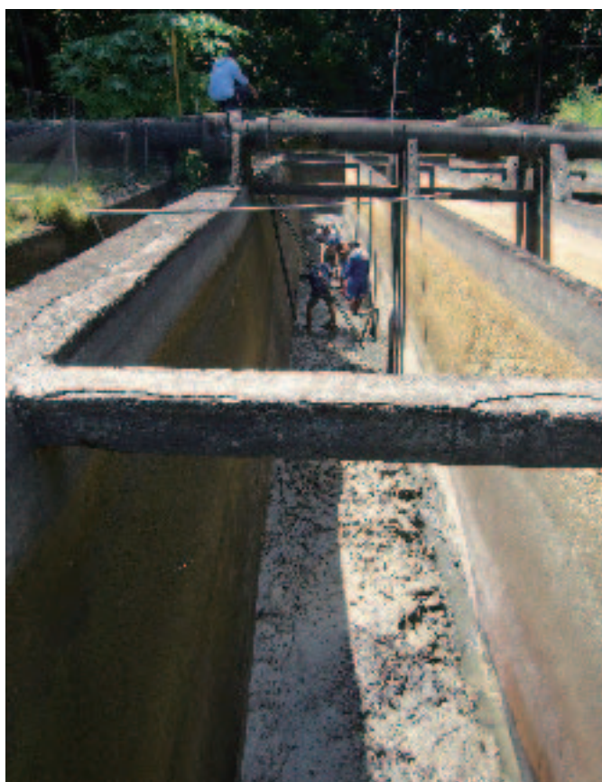
■浄水場での現地調査
