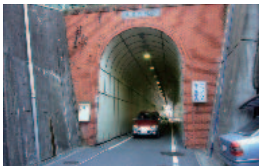
■本文では紹介出来なかった民間由来の古参、筒井隧道。明治38年の完成だが、後に峠道の勾配を緩めるために路面を切り下げた結果、このような縦長の姿になった
