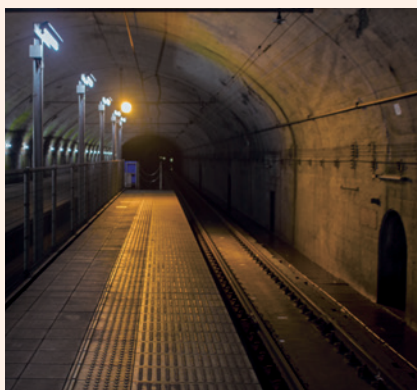
■新清水トンネル内にあるホーム
