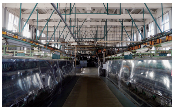
■繰糸所内部（トラス構造の様子）
