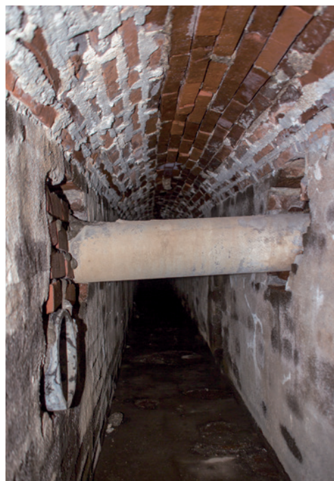
■煉瓦積排水溝内部
