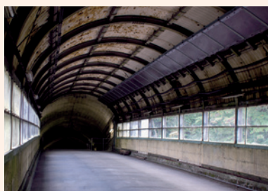
■道路や河川の上空を渡る連絡通路
