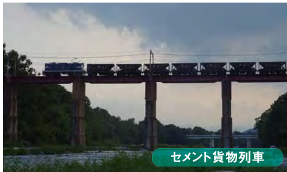
夕暮れの荒川橋梁
