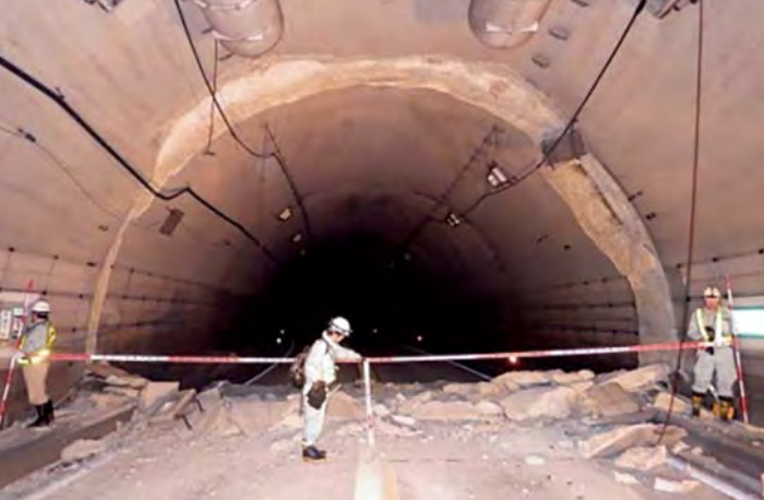
■坑内崩落箇所点検
