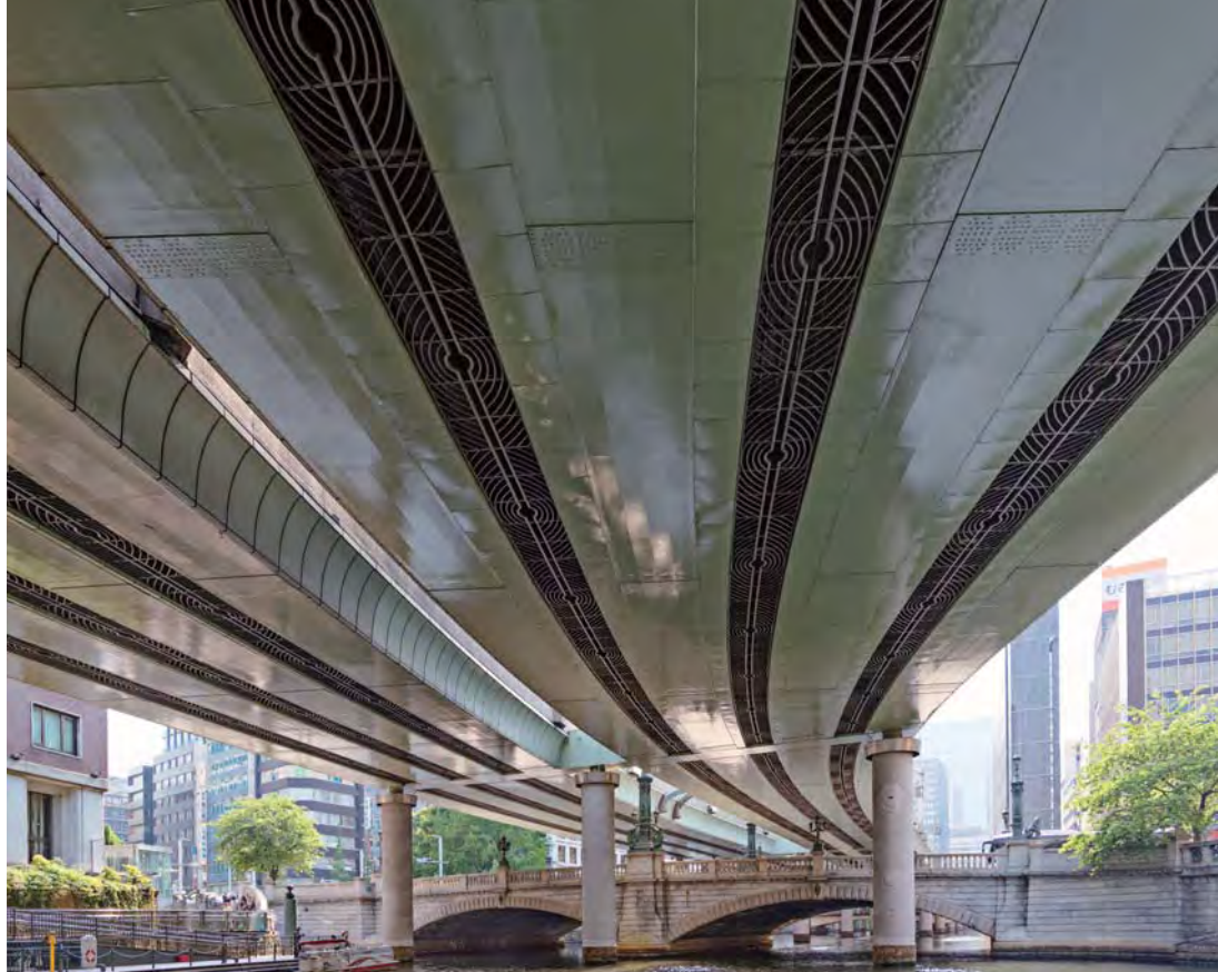
■ジャンクションツアー：日本橋付近（首都高速道路：都心環状線）
