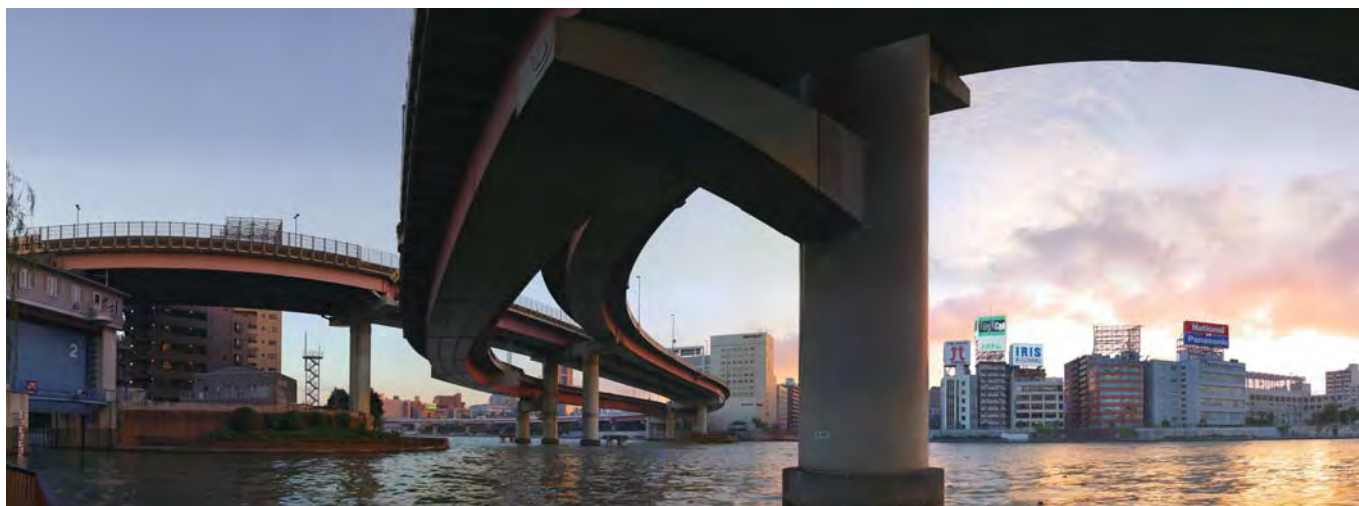
■景観とマッチする構造風景：両国 JCT (首都高速道路；向島線・小松川線)
