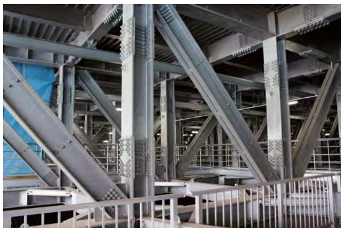
■長さ約 35 m、重さ 500 トンもあるメガトラス
