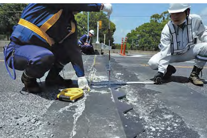
■道路緊急点検
