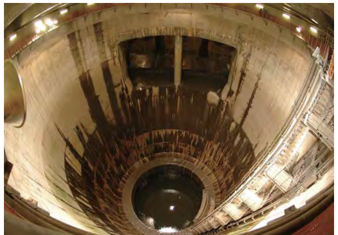
■第1立坑の様子
