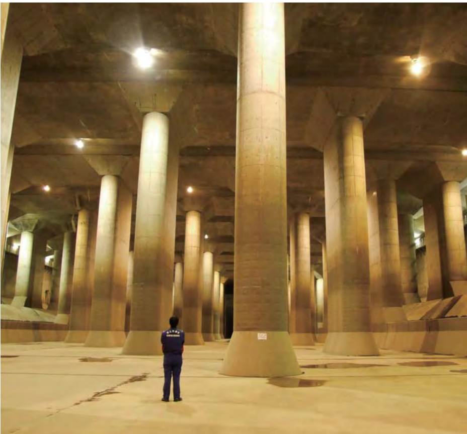
■パルテノン神殿とも呼ばれている調圧水槽
