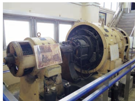
■資料館 1 階に置かれている変電設備
