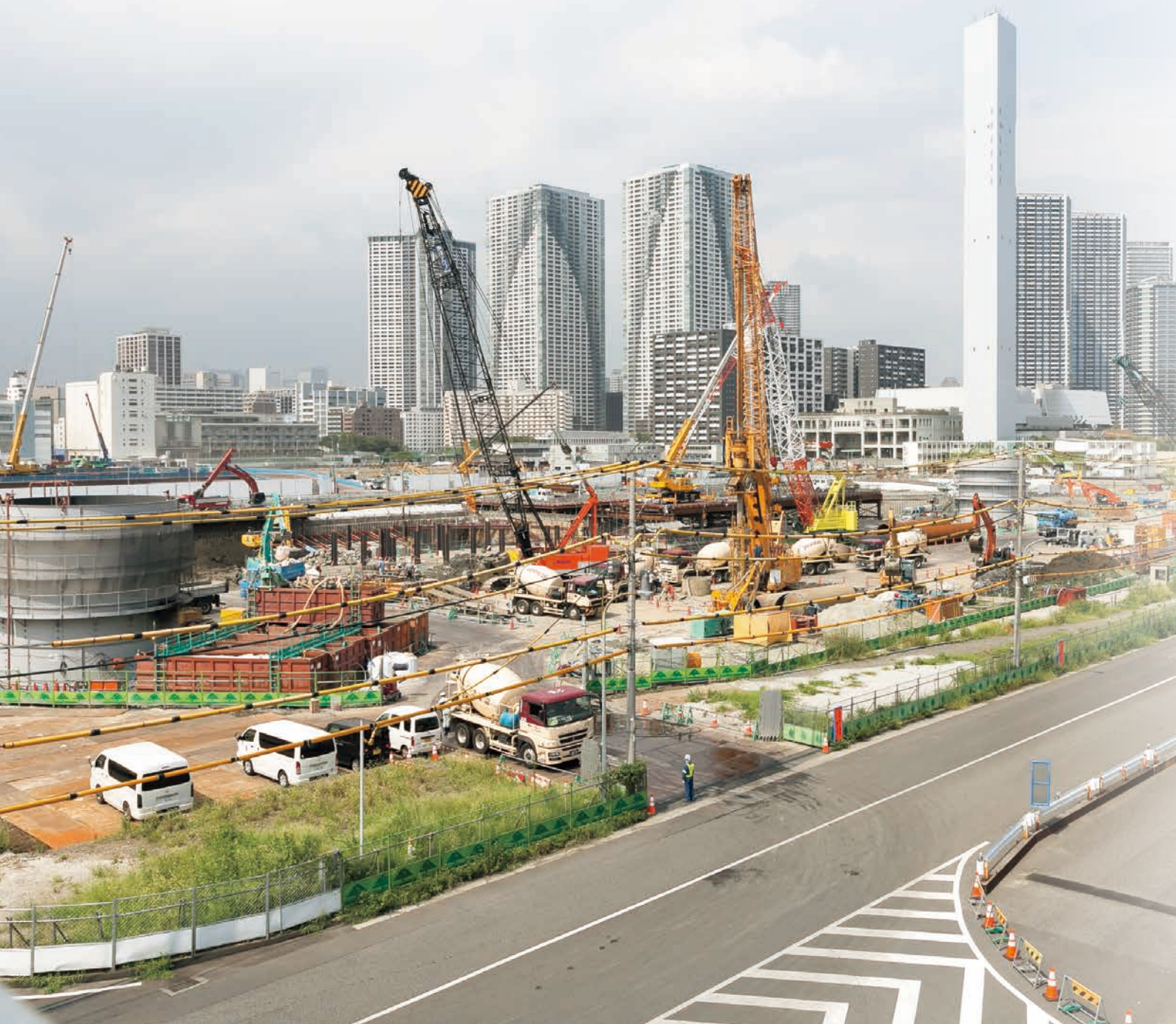
選手村工事中の状況
