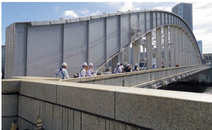
■橋脚部へ向かっているところ
