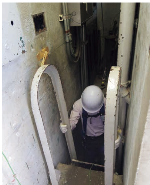
■橋脚内へ恐る恐る降りる
