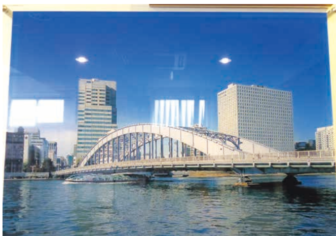
■資料館に展示されていた勝開橋
