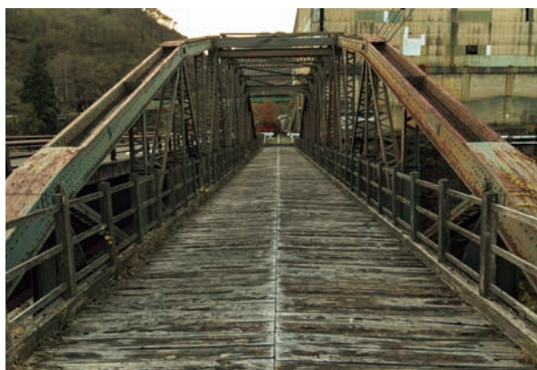
■現在の古河橋
