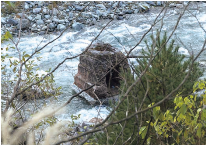
■原動所跡の基礎部分
