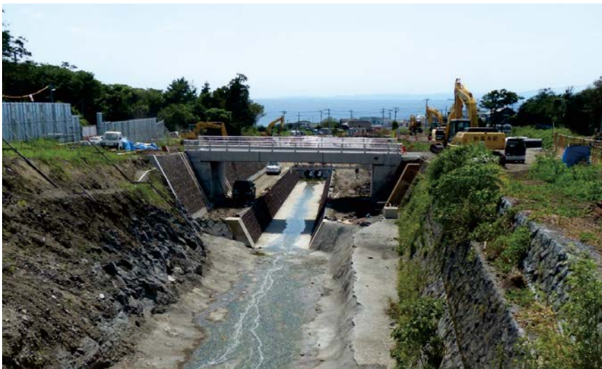
■元町地区の流路工の整備工事、現在も恒久対策が進められている
