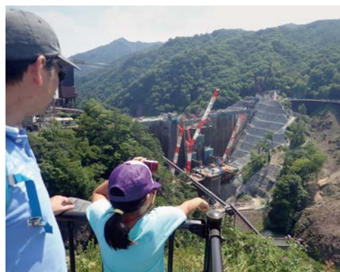
■「やんば見放台」から工事現場を見学
