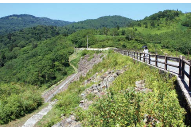
■ロックフィルダムの特徴が分かるダムサイトの下流側
