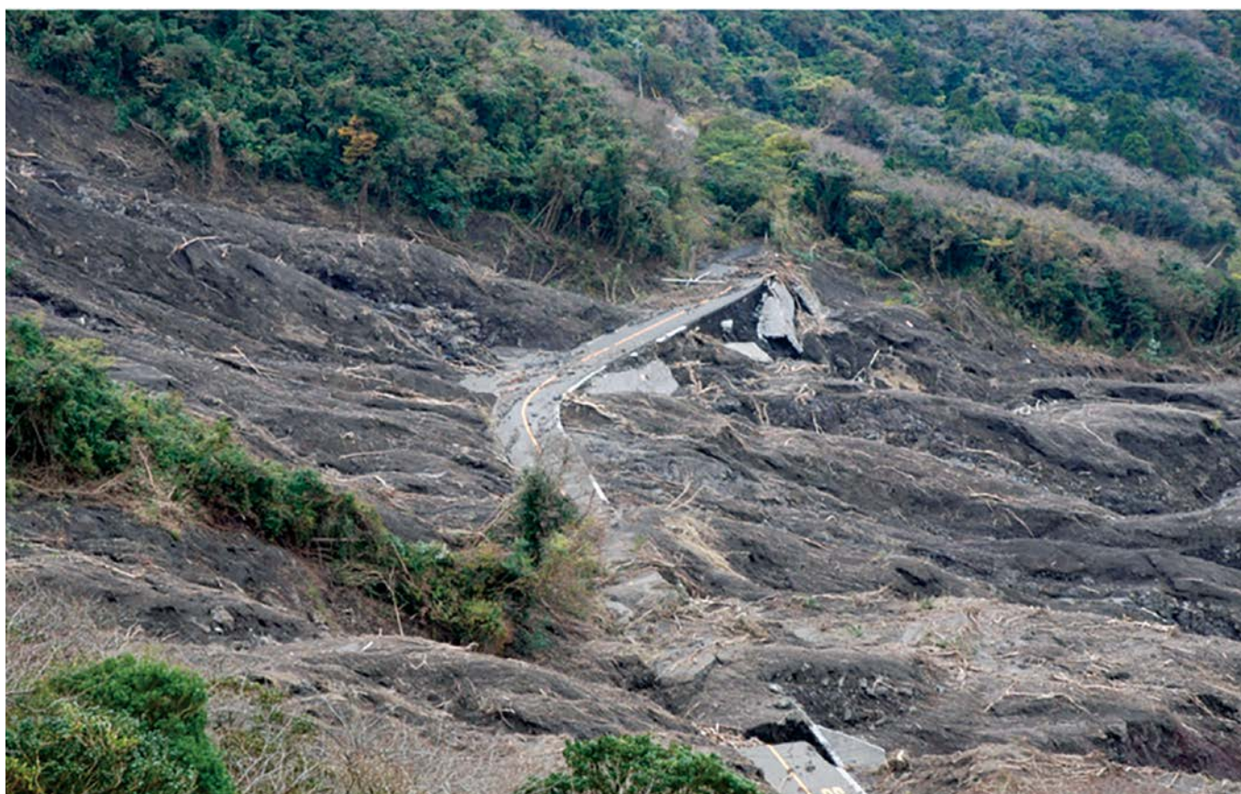
■土石流の横断による道路の崩壊状況（日本工営株式会社 藤木氏提供）
