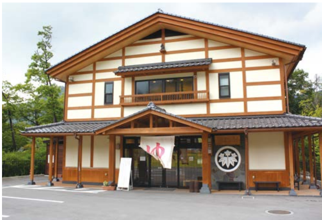
■高台移転後の新「王湯」
