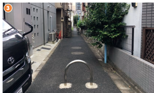
■ 連続する古いマンホール。盤面を見ると同時期に敷設、暗渠化されている
