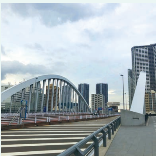
■環状第2号線にかかる築地大橋
