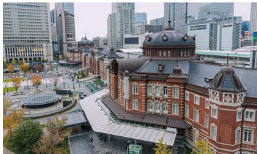
■写真3 復元された丸の内駅舎の横顔
