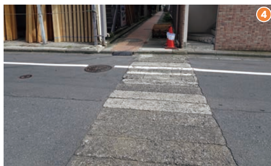
■ 道路を横断して続く暗渠。アスファルトに埋め込まれた古いコンクリート蓋も特徴的
