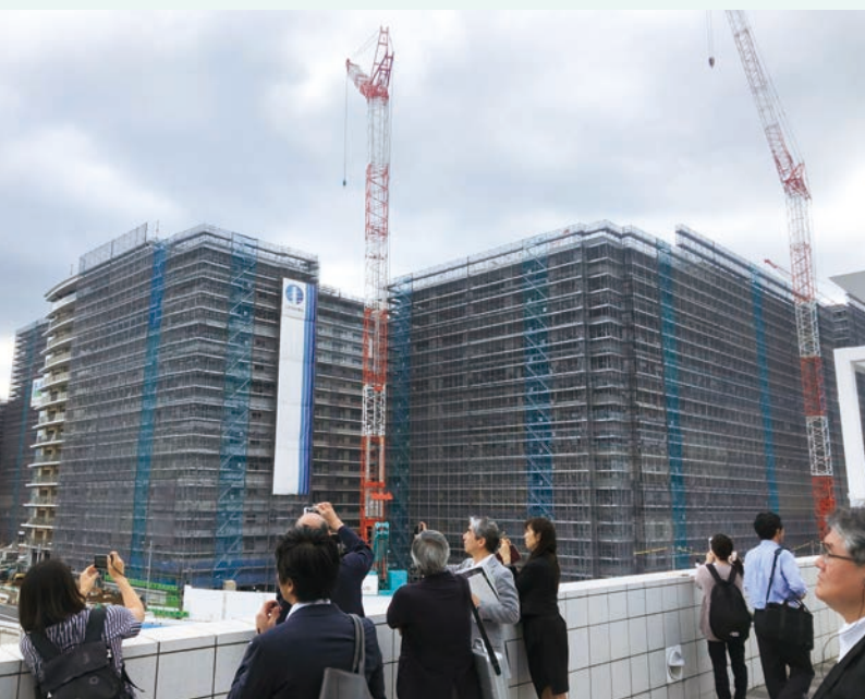
■晴海客船ターミナルより選手村工事現場を俯瞰。着々と完成に近づいている。
