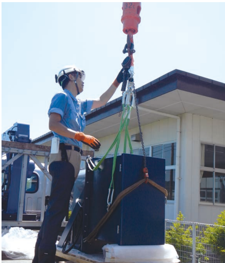
■白河市で小水力発電設置の様子
