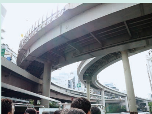
■船から見上げる首都高速道路
