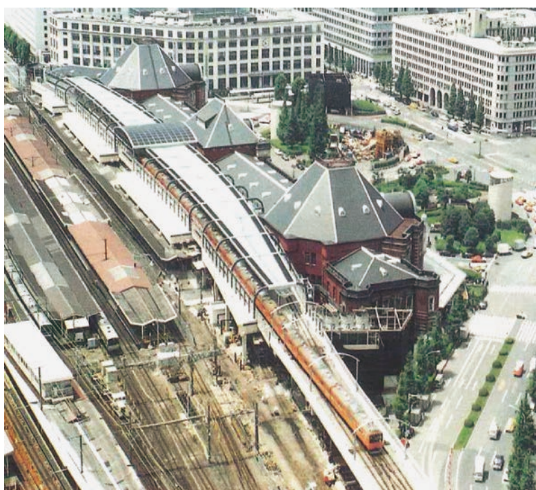
■写真3 中央線重層化（施工後；写真右が丸の内側）
