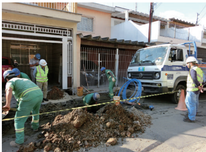
■給水管の取り替え工事の様子
