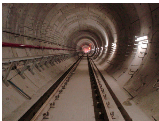
■トンネル坑内
