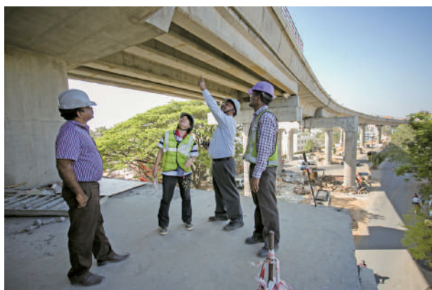
■高架駅構築中
