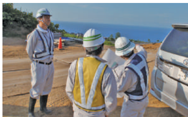
■現場で工事進捗状況の確認
