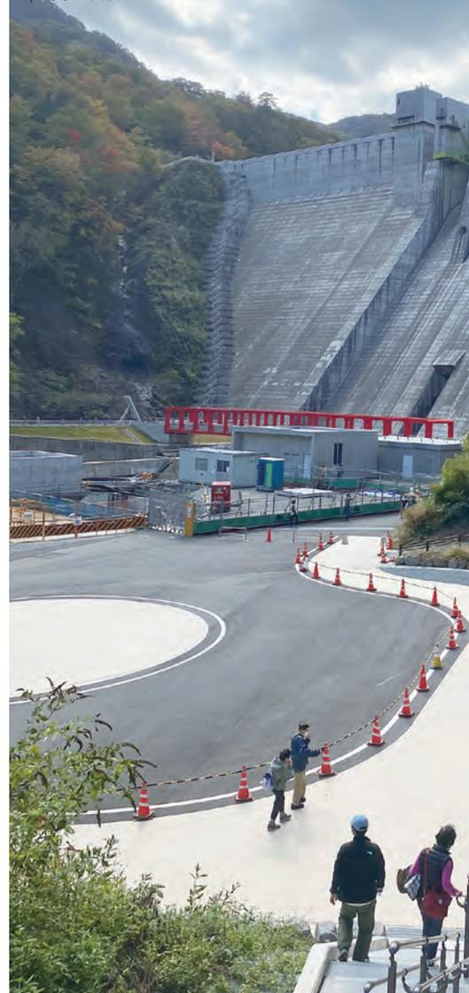
定名勝・吾妻峡の保護の観点からダムの計画位置が変更。紆余曲折を経て、2015年にようやくダム本体左岸の掘削工事が始まり、2019年10月1日に試験湛水を開始。徐々に水位を上げる予定が、台風19号の影響により一気に水位が上がり、2019年10月15日には平常時最高貯水位の標高583mに到達し注目を集めた。2020年3月31日に完成し、同年4月1日から運用開始。選択取水設備という29段のサイフォン管を積み上げた連続サイフォン式を採用し、取水範囲は58mとこの方式で国内最大を誇る。
